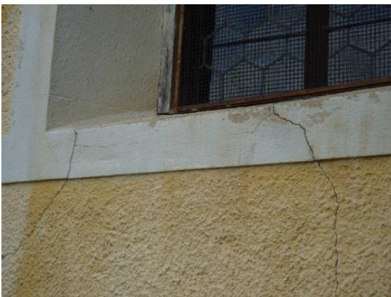
Risse im Kreuzgewölbe und an der Aussenfassade
